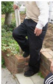
これが36cmの段差です。結構高いです。
