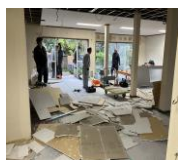
①地階 壁・天井
